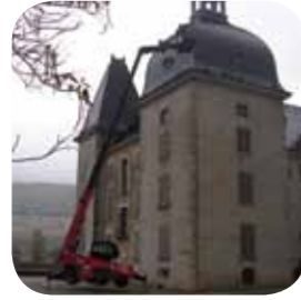
ROOFING TELHADOS CUBIERTAS
