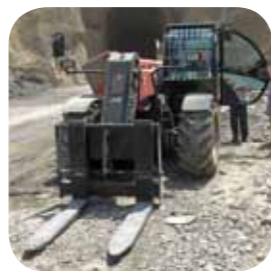
TUNNELS TÚNEIS GALERÍAS Y TÚNELES
