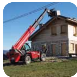
CIVIL MANUTENÇÕES CIVIS MANTENIMIENTO CIVIL
